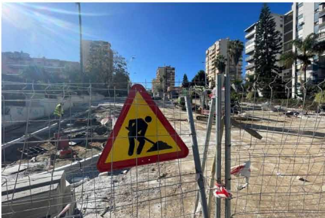
Obras en San José Artesano, en Algeciras.
