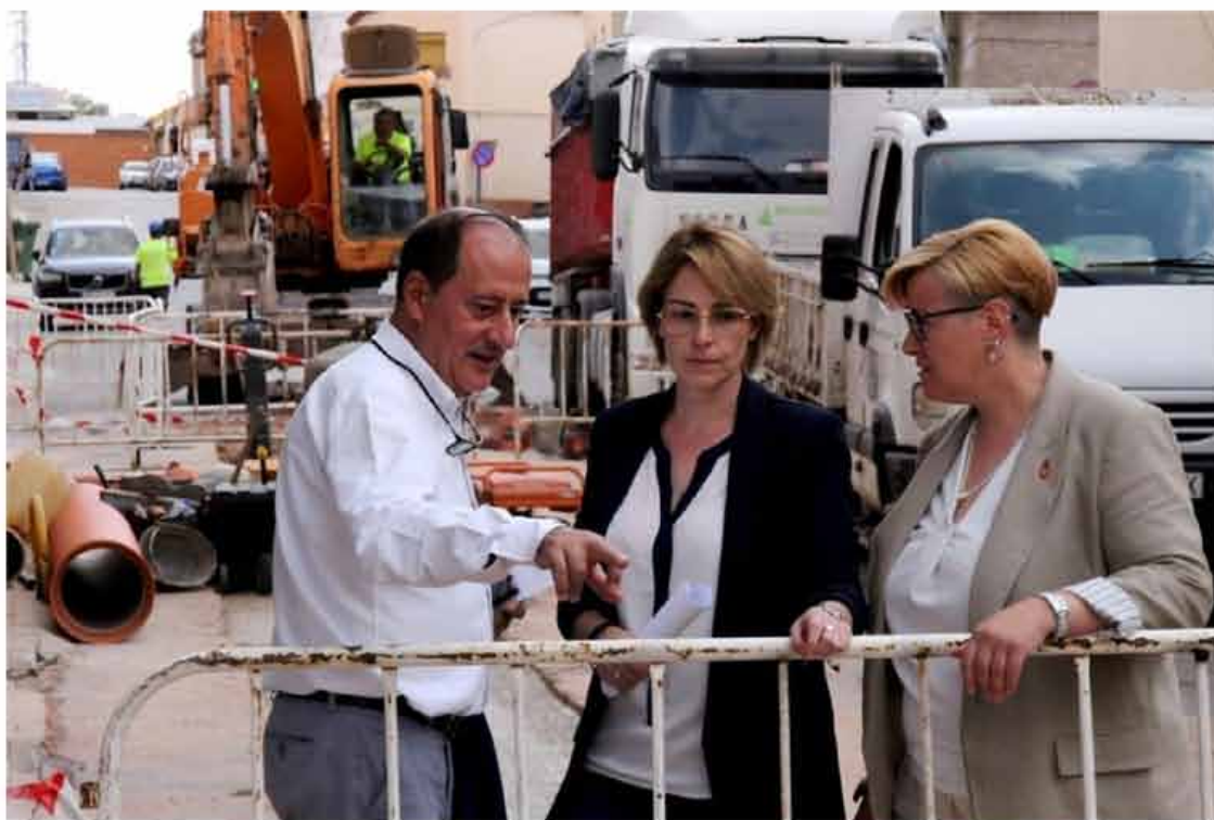
La alcaldesa visita las obras en la calle Severo Ochoa / Lanza
