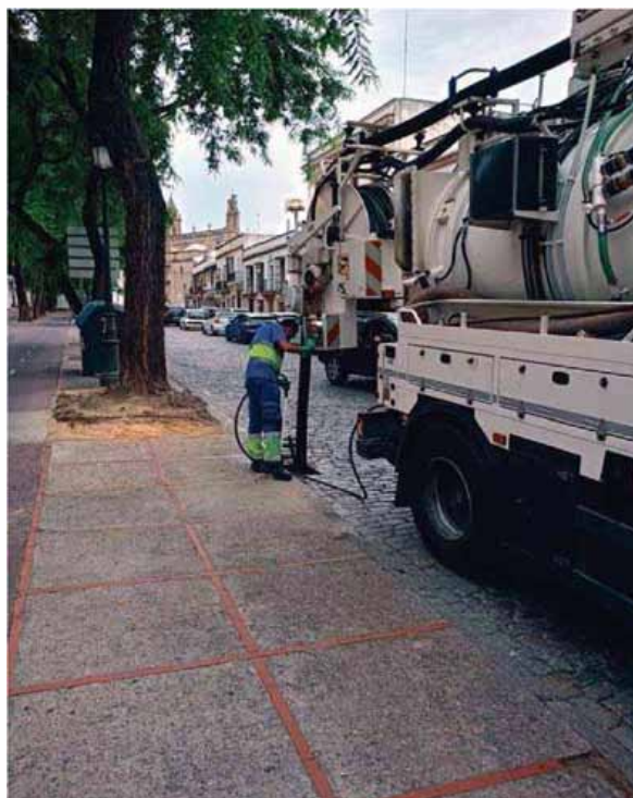
Un operario de Aquajerez maneja una tobera en la calle Ancha. CEDISA
