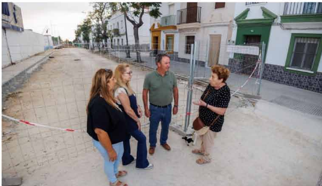
Los vecinos, en la zona afectada por las obras de gran magnitud.
