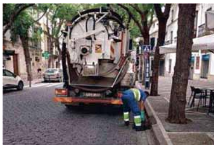
Inspección manual de un imbornal en la céntrica calle Porvera. CEDISA
