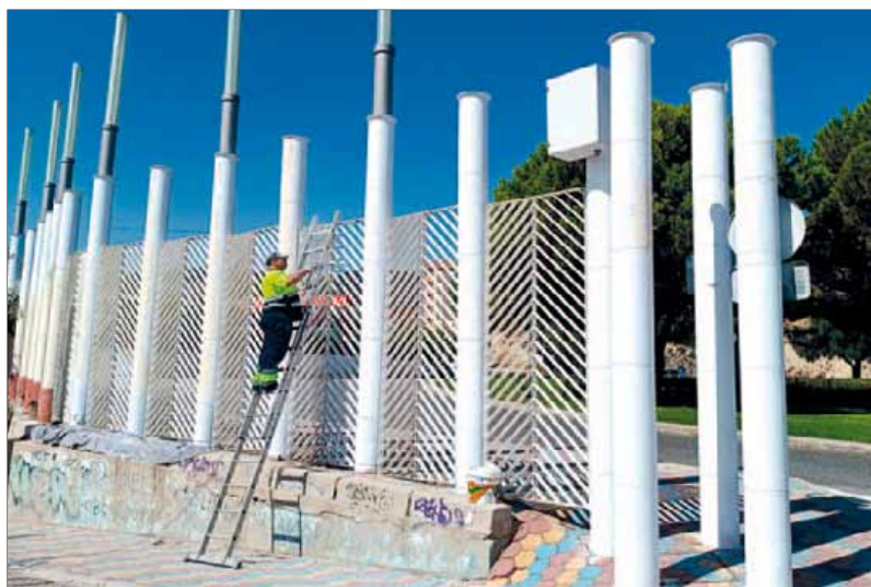
PUESTA A PUNTO. Un empleado renueva la pintura de las columnas del recinto ferial.
