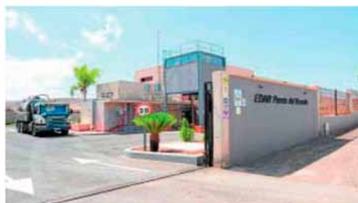
Depuradora de Puerto del Rosario. JAVIER MELIÁN / ACFI PRESS
