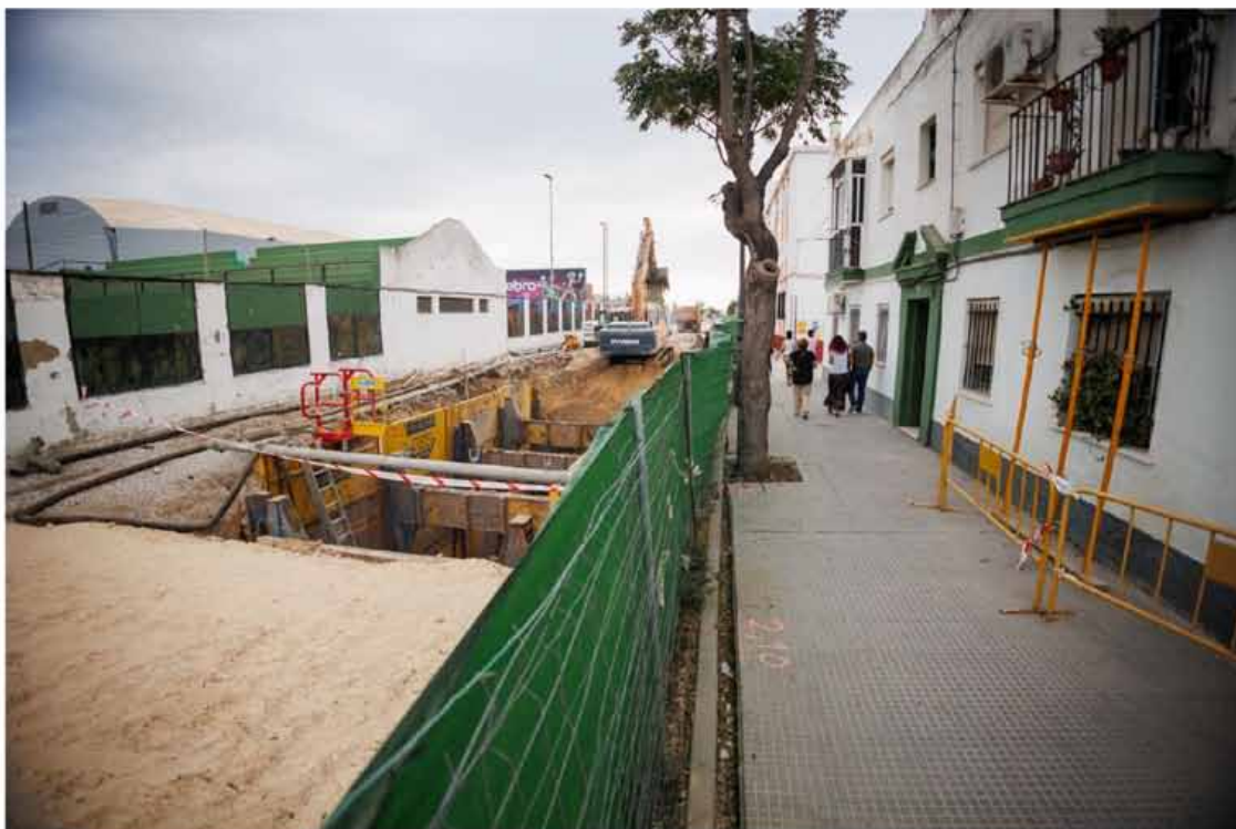
Los vecinos caminan junto a la obra del tanque de tormentas en la avenida de la Bajamar, en El Puerto.
